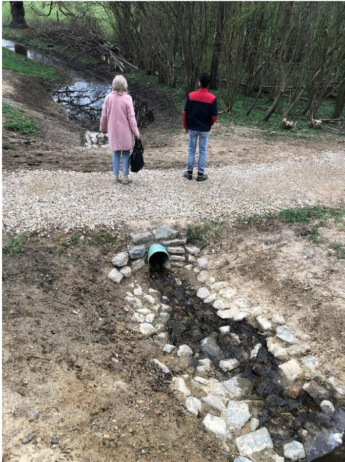
Afbeelding 7. De projectgroep neemt een kijkje tijdens de afronding van de werkzaamheden.
